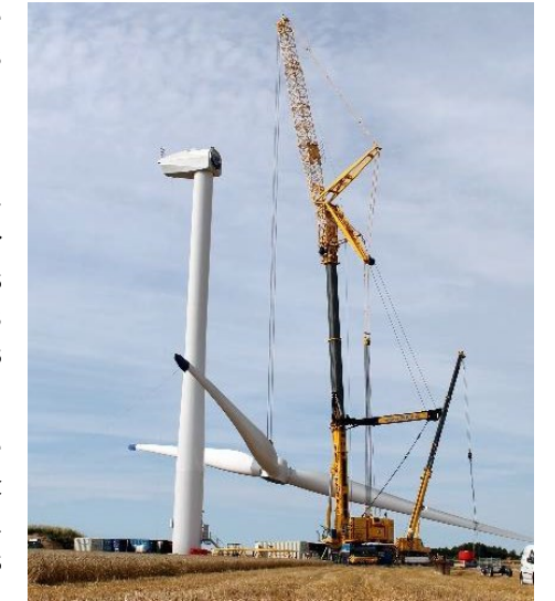
Photographie 3 : Assemblage d'une éolienne sur le parc de Mancheville (76) (source EDPR)
