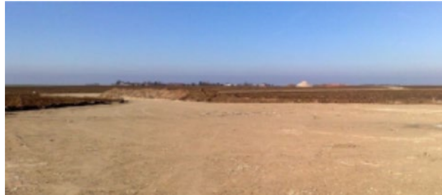
Photographie 4 : Exemple d'aire de montage, grave compactée sur géotextiles (source : EDPR France Holding)
