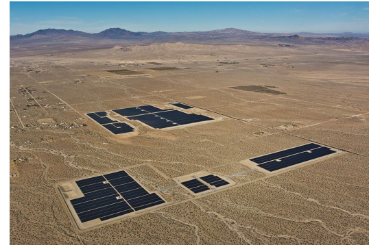
Photographie 2 : Le parc solaire de Lone Valey aux Etats-Unis (source EDPR)
